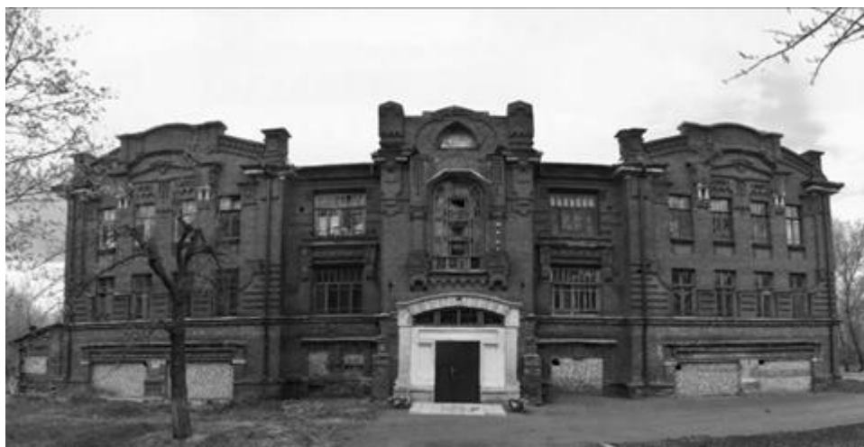
Рис. 1. Здание Алешковского сельскохозяйственного техникума
