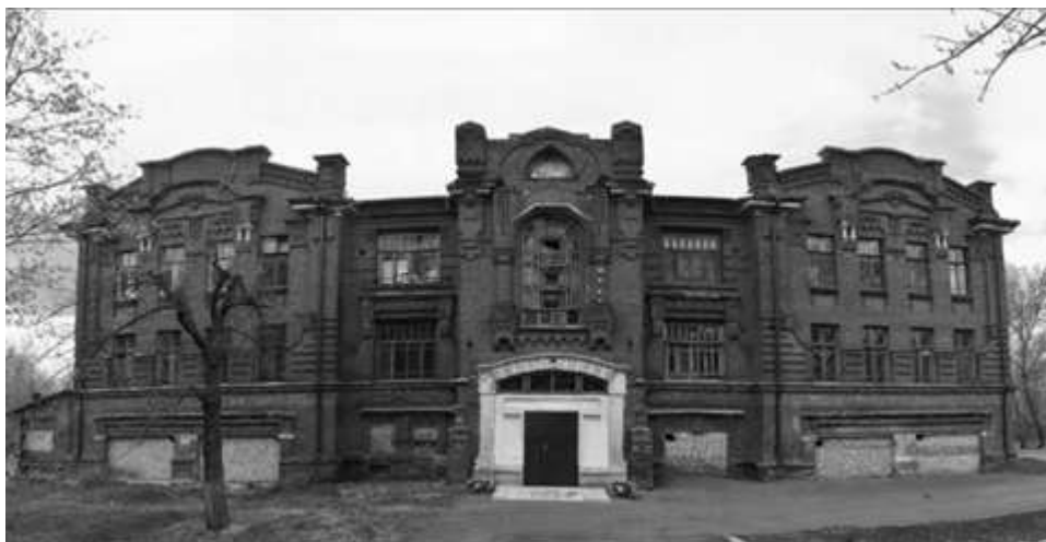
Рис. 1. Здание Алешковского сельскохозяйственного техникума
